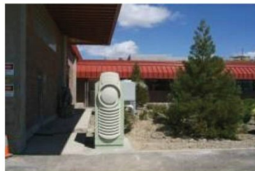
На кемпинге: - Микротурбина 30 кВт.
