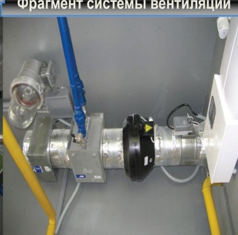
Система газовой безопасности. Автоматический клапан
