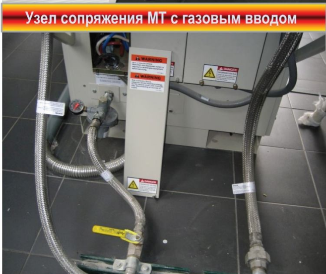
Система газовой безопасности. Автоматический клапан
