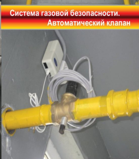
Узел сопряжения МТ с газовым вводом
