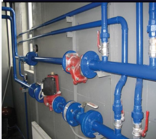
Тепловой контур с циркуляционным насосом
